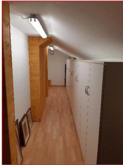
Neu geschaffener Archiv-Raum
